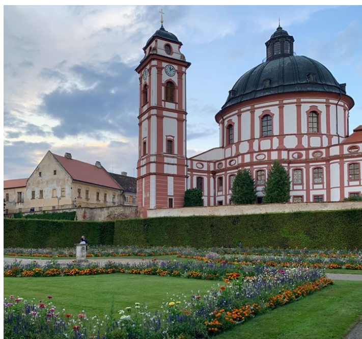
Chrám sv. Markéty čeká nákladná oprava.
